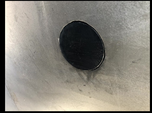
3、打設口閉(打設終了)
