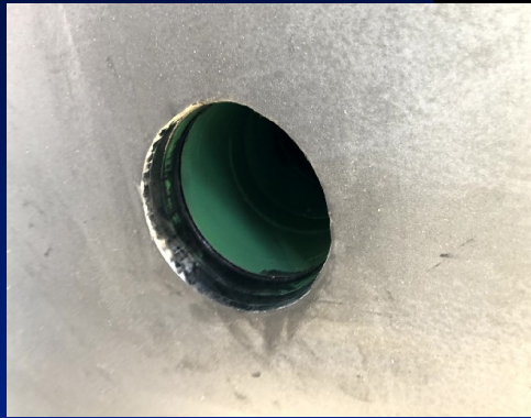
1、打設口開(打設前)
